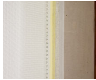
Junta del dilatacion para angulo
